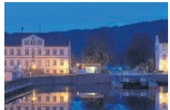
Unser Foto entstand am Abend zur blauen Stunde. Zu sehen sind auch Teile der neuen Steganlage, an der noch gebaut wird.
