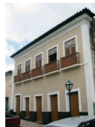
RUA DO GIZ Nº 393
