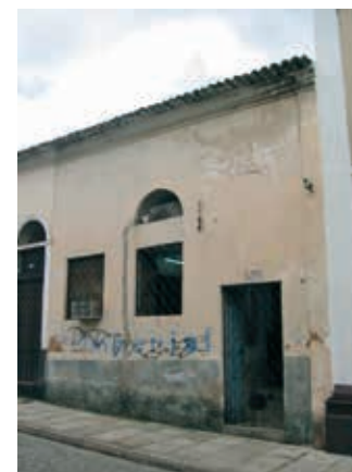
RUA DO GIZ Nº 385
