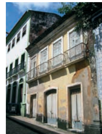
RUA DO GIZ Nº 39
