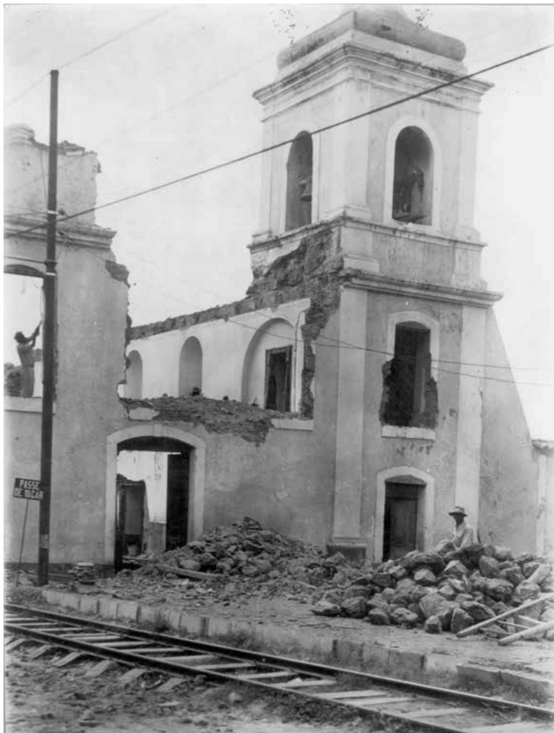
Igreja da Imaculada Conceição dos Mulatos em demolição a partir de 1939. Arquivo Central do IPHAN – Seção Rio de Janeiro (Noronha Santos).
