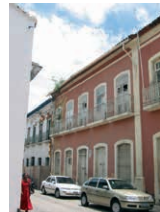
RUA DA ESTRELA Nº 415
