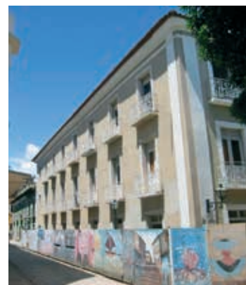
RUA DA ESTRELA Nº 201/241
