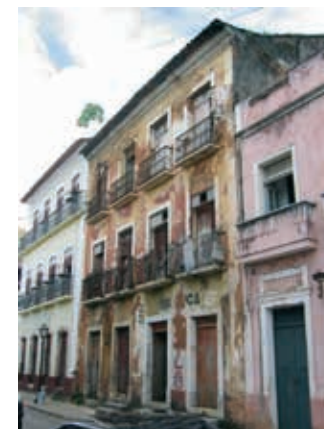
RUA DO GIZ Nº 295
