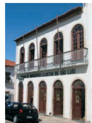
RUA DA ESTRELA Nº 508
