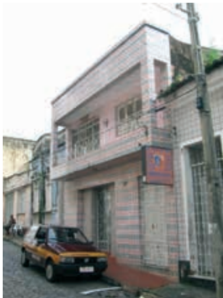
Endereço: Travessa da Passagem, 126
