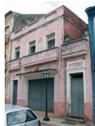
RUA DO GIZ Nº 305
