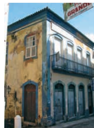
RUA DA ESTRELA Nº 370
