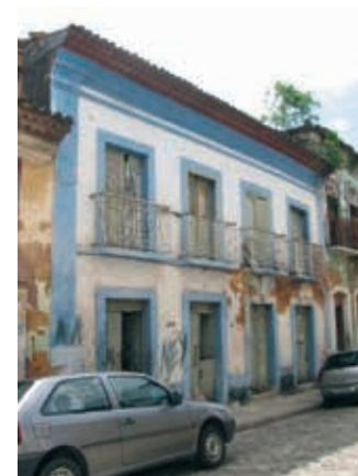
RUA DA ESTRELA Nº 547
