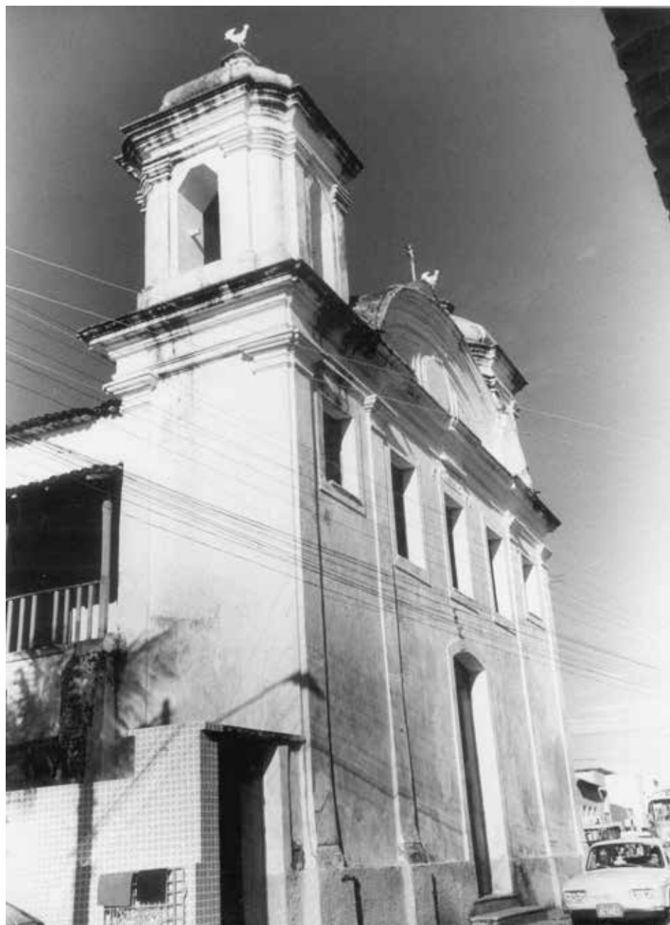
Igreja de Santana. Construída em 1791, esta igreja foi, em 1801, a matriz da primeira freguesia que se criou depois da freguesia de Nossa Senhora da Vitória, que foi a única na cidade até esta data. Arquivo Central do IPHAN – Seção Rio de Janeiro (Noronha Santos).
