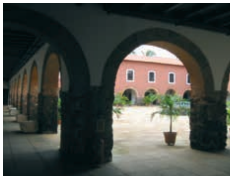
RUA DA PALMA Nº 502 - CONVENTO DAS MERCÊS - ARCADA
