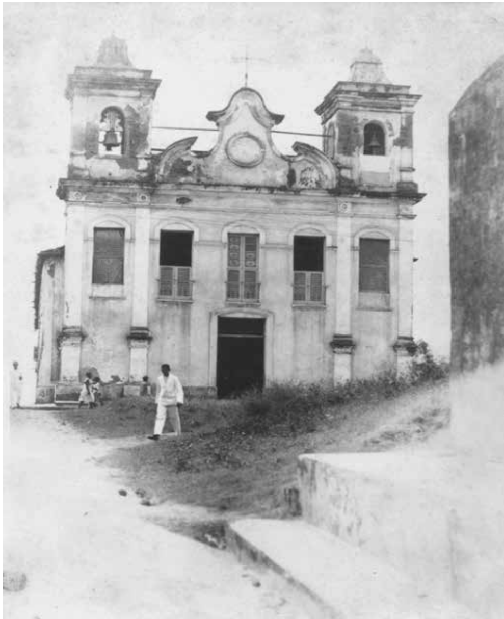
Igreja de São Pantaleão. Pertencente à Santa Casa da Misericórdia, esta igreja sofreu várias reconstruções e mudanças. Em 1817, foi celebrada a primeira missa com a chegada da imagem de São José. Arquivo Central do IPHAN – Seção Rio de Janeiro (Noronha Santos).
