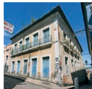
RUA DA ESTRELA Nº 386
