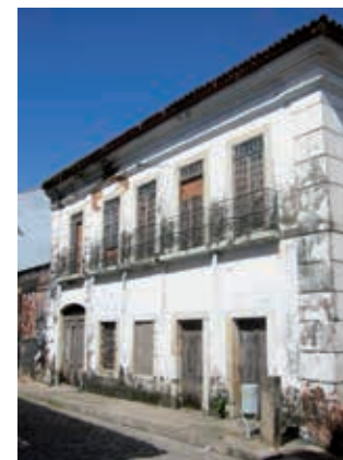
RUA DA ESTRELA Nº 540
