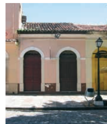
RUA DA ESTRELA Nº 202
