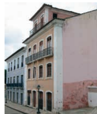
RUA DA ESTRELA Nº 124
