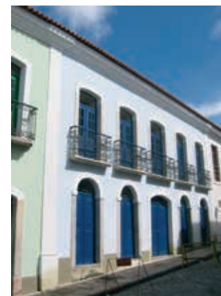
RUA DA ESTRELA Nº 472
