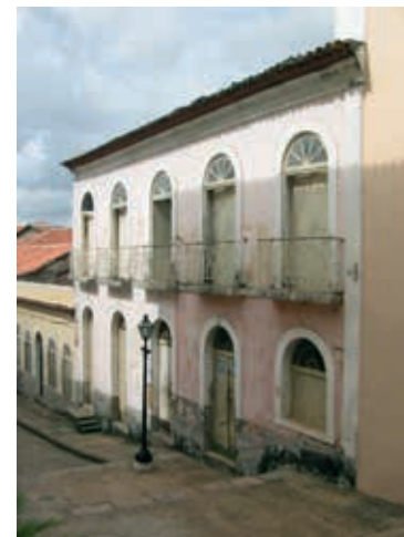
RUA DO GIZ Nº 34
