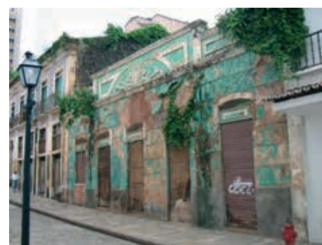
RUA DA ESTRELA Nº 129
