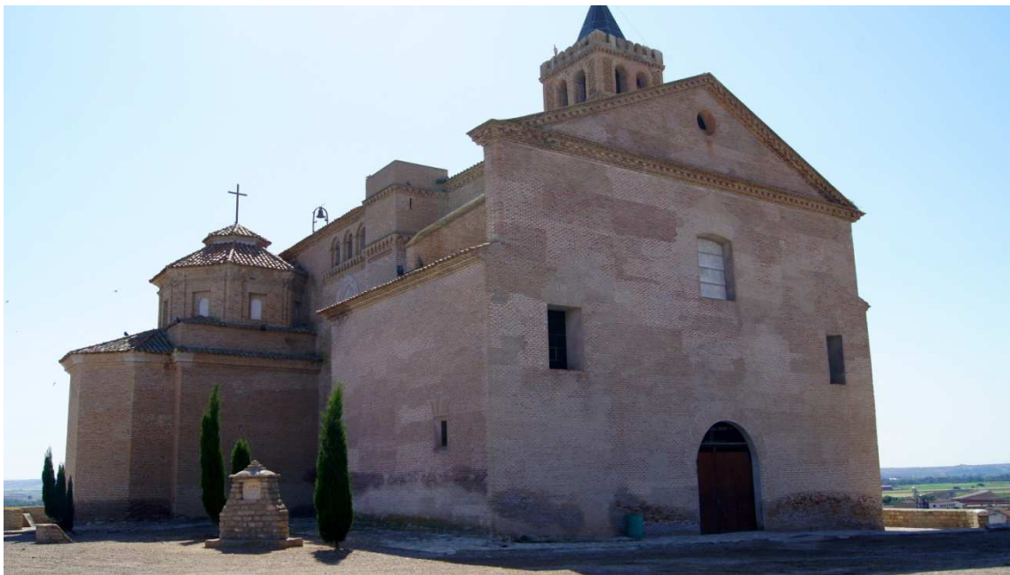
Fig. 45 Exterior restaurado donde se aprecia su belleza original. Junio 2017.
