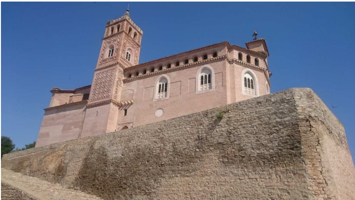
Fig. 16 Actualmente la torre se encuentra en la parte central del muro sur. Junio 2017.
