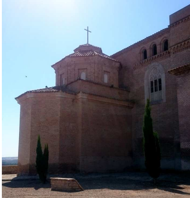
Fig. 25 Exterior capilla Santa Ana . Junio 2017
