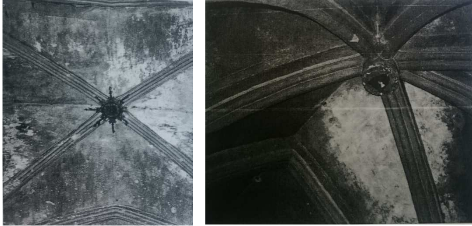
Fig. 32 Encintados en las claves de las bóvedas los cuales enmarcaban escudos hoy desaparecidos. Octubre 2004.
