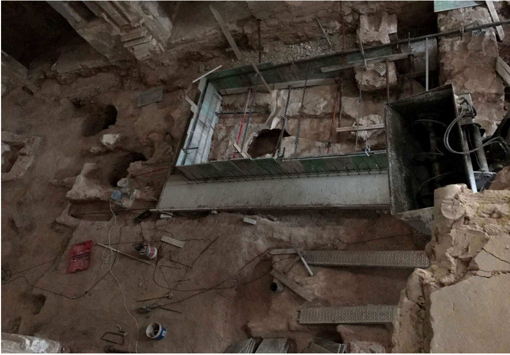
Fig. 40 Acondicionamiento del suelo de la nave central para instalar una cristalera. Junio 2017.
