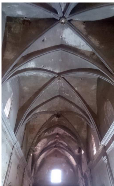
Fig. 22 Bóvedas de crucería simple nave central. Junio 2017
