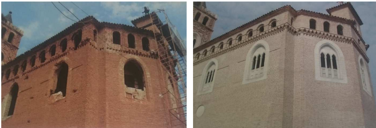
Fig. 39 Renovación de fachadas 1996 – 2003.
