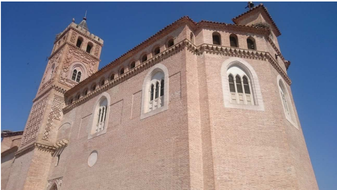
Fig. 12 Galería con diferentes arquillos: en el ábside son apuntados y en el resto de la nave de medio punto doblados. Junio 2017
