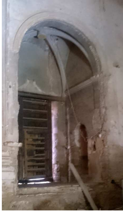
Fig. 27 Acceso portada sur y subida torre. Junio 2017
