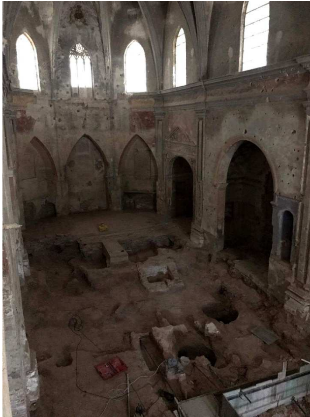
Fig. 36 Obras en el interior fase 13. Junio 2017
