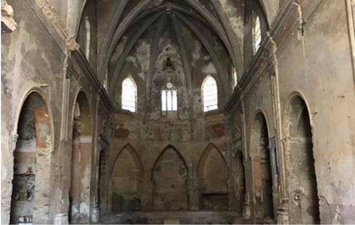
Fig. 19 Ábside poligonal de cinco lados cubierto con bóveda nervada. Junio de 2017.
