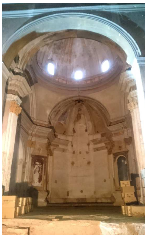
Fig. 24 Interior capilla Santa Ana (1761). Junio 2017.
