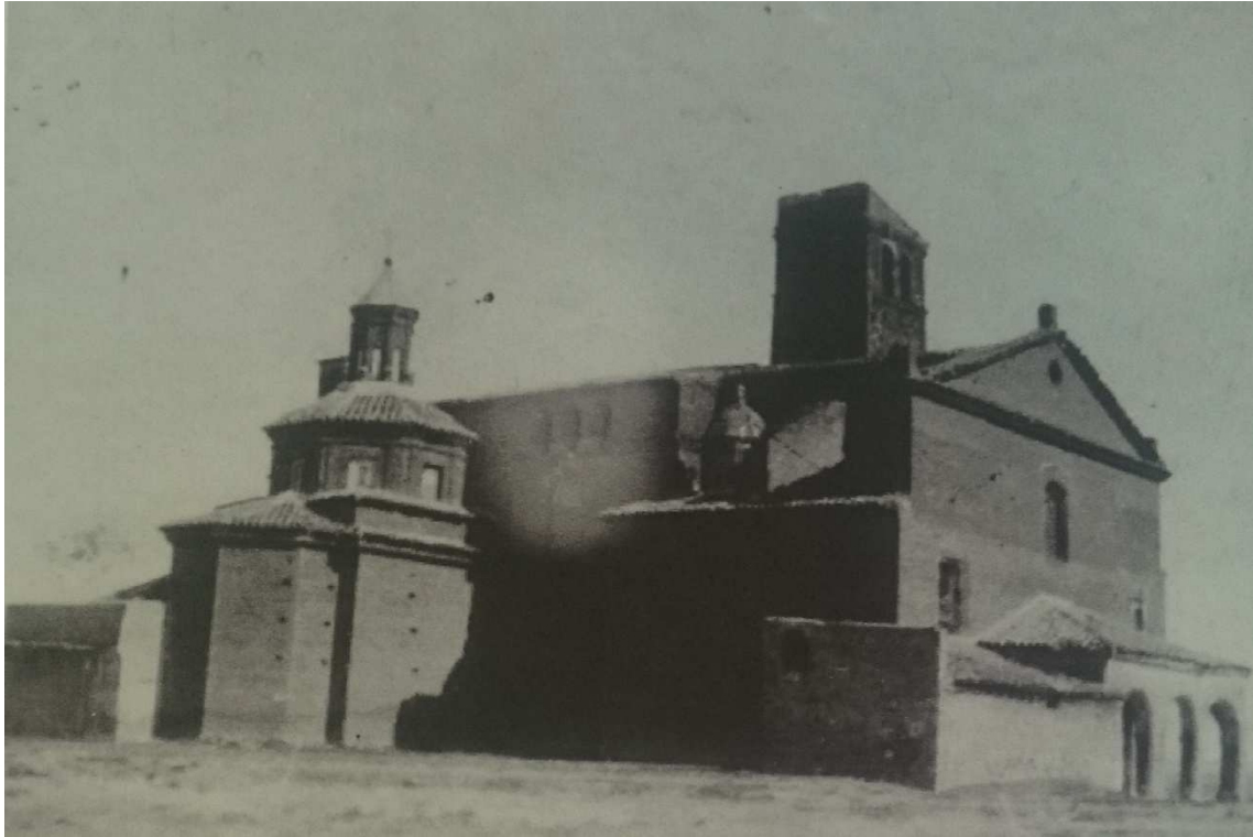
Fig. 34 Edificio antes de la Guerra Civil.
