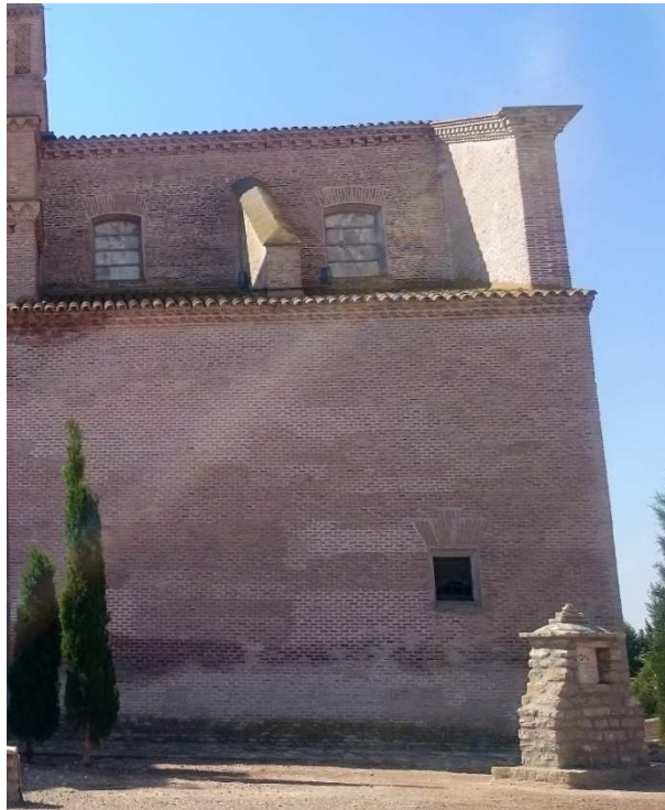
Fig. 31 Ventanales ampliación época moderna. Junio 2017
